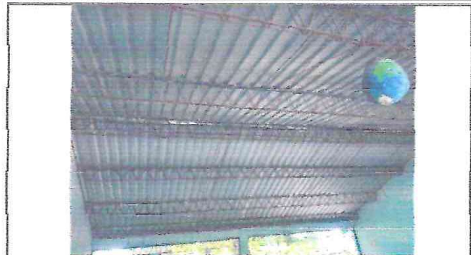
Foto 2: Cambio de Estructura Metalica
